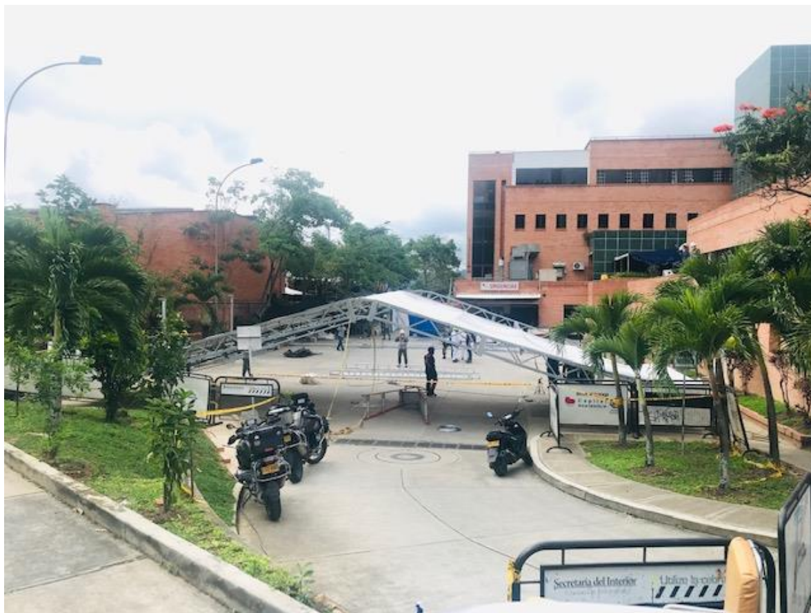
Montaje de estructura cubierta plegada 2 aguas.
