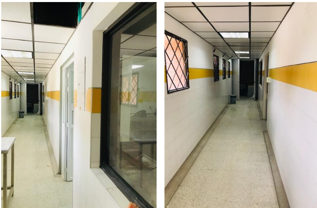
Limpeza de corredor y traslado de acometida eléctrica para cámara de flujo laminar.
