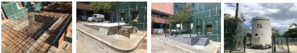
Fotografía 50. Construcción de Base E Instalacion del Tanque Criogénico
