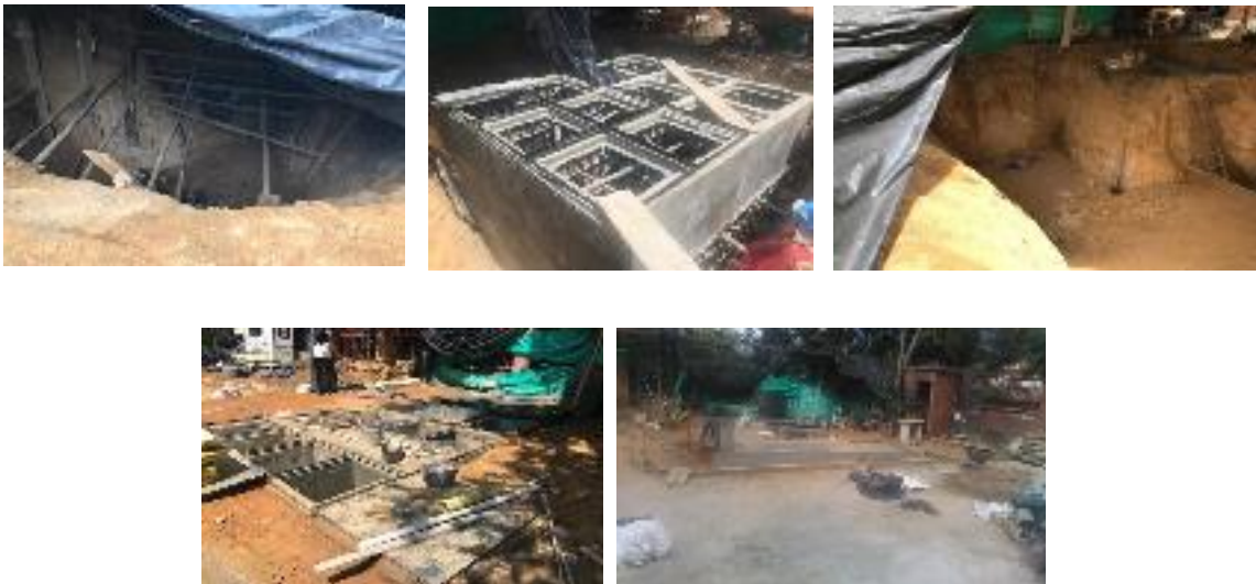
Fotografía 59. Construcción del sistema de tratamiento de aguas residuales no domésticas
