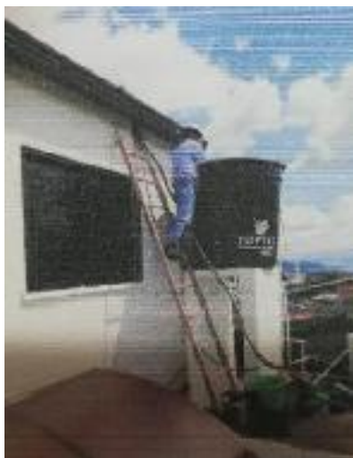
Fotografía 29. Desinfección de tanque
