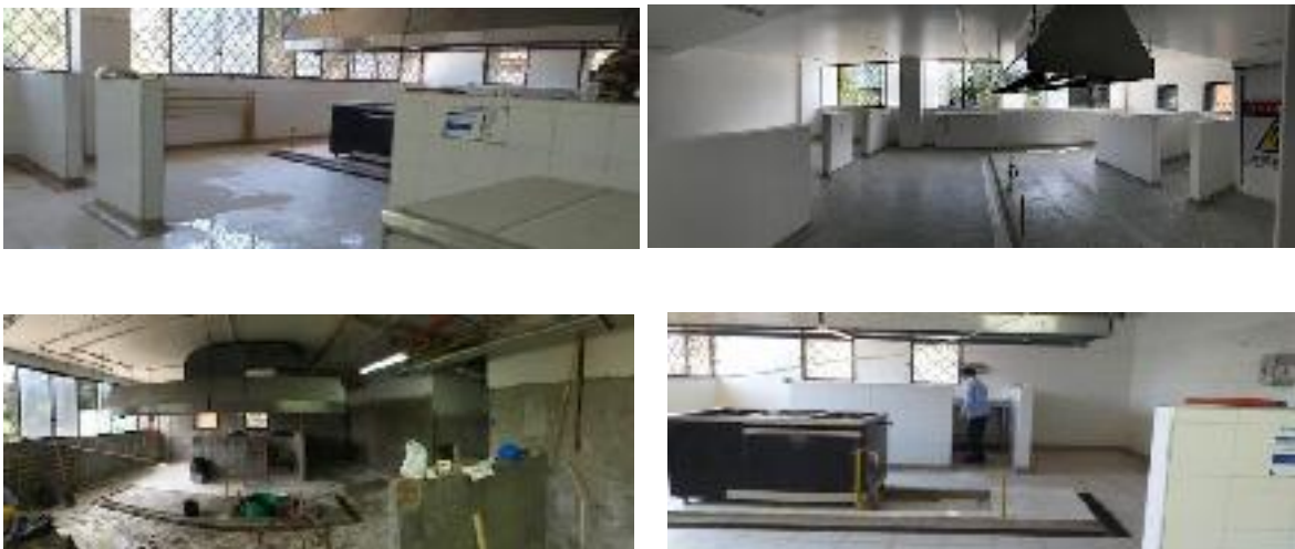
Fotografía 58. Cocina Hospital Local del Norte
