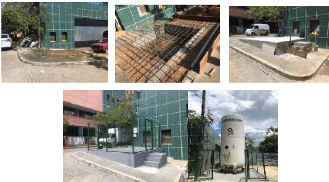
Fotografía 57. Construcción base de Concreto para el Tanque de Oxígeno
