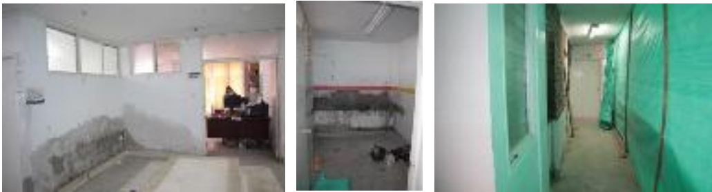
Fotografía 62. Mantenimiento Centro de Salud Concordia vigencia 2017
