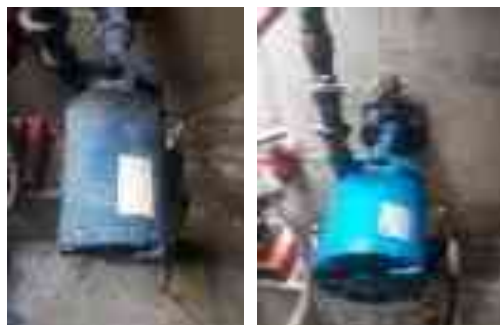
Mantenimiento y pintura de carcasa de electrobombas
