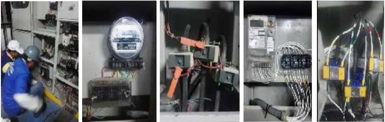
Fotografía 52. Mantenimiento Parte eléctrica UIMIST
