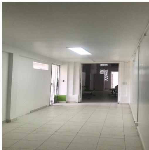
ZONA DE AISLAMIENTO PEDIATRICO Y CORREDOR MATERNO A CIRUGIA
