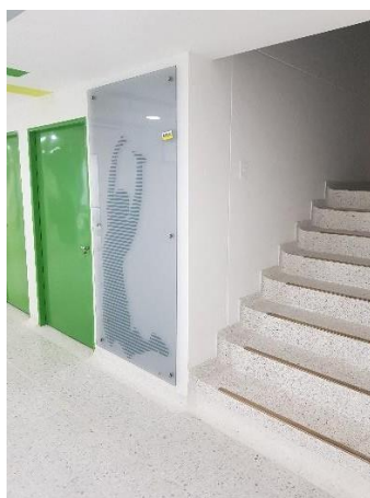
INSTALACIÓN DE VINILO SOBRE VIDRIO TEMPLADO, PRIMER PISO.
