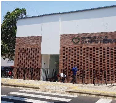
INSTALACIÓN DE LETRERO DE FACHADA DEL CENTRO DE SALUD.
