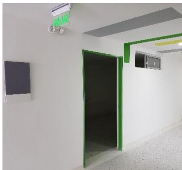
PINTURA DE FRANJAS EN CIELO RASO.
