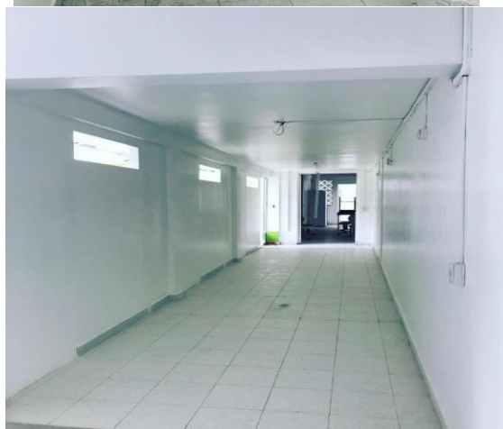
CORREDOR MATERNO, PINTURA GENERAL ANTIBACTERIAL , INSTALACION DE MURO EN SUPERBOARD PARA SEPARAR EL PARQUE INTERNO Y SALIDA DE ELEMENTOS SUCIOS.
