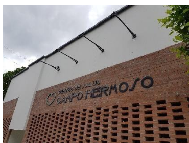
INSTALACIÓN DE REFLECTORES SOBRE LETRERO DE FACHADA.
