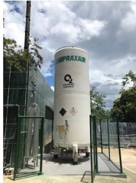
Se realizó construcción de base para tanque criogénica, realizada en cemento reforzada de 5000psi, esta estructura resistirá peso aproximado de 16 toneladas, encargado de soportar tanque de almacenamiento criogénico. Se realizó en terreno pleno en cual se hacen variables de nivelación dejando como nivel máximo de estructura -1,50mt y máximo nivel, 20cm, este se realiza con estructura confinada y fundida con equipo de mezcla certificado.
